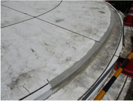
ステージの破損を補修
